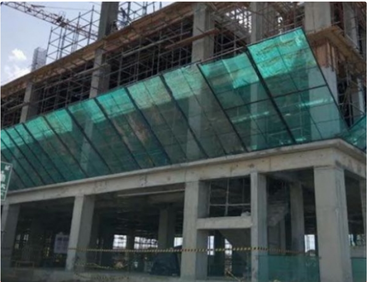
Gedung baru RSUD dr Soedomo dalam pembangunan
